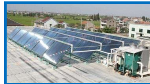
Solar Cooling Napkollektoros hűtés
