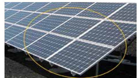
Napelem csoport „panel”. Nem azonos a „field” (mező) vagy „array” (tömb) megnevezéssel. Ez utóbbiak villamos szempontból is összetartoznak
