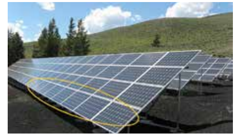
Napelem fűzér (max.7-10 napelem, V_{oc} feszültségtől függően)
