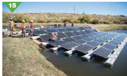
Úszó napelemek telepítés közben
