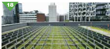
Kétoldalas napelemek egy iskola lapostetős épületén
